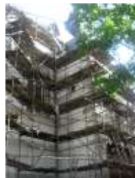
oprava jižní stěny kostela
