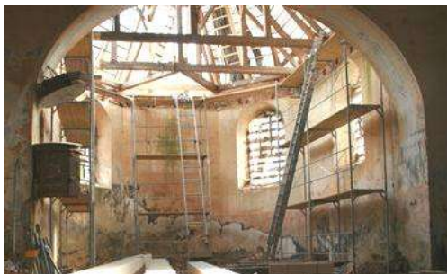
Foto z rekonstrukce trámů a latí nad presbytářem kostela sv. Linharta
