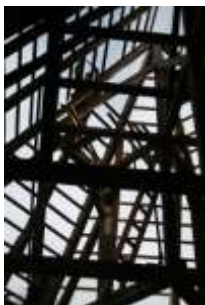
Foto z rekonstrukce trámů a latí nad presbytářem kostela sv. Linharta
